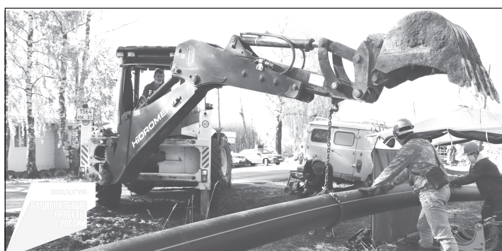
Работы по строительству объектов инженерной инфраструктуры начались
